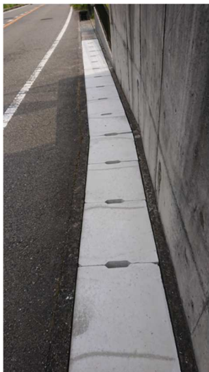
2021.06.25／07.06 側溝蓋設置（三田市道路許可下付）
