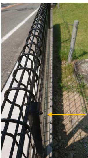
2021.06.25 フェンス基礎の TOP 部分のコンクリート仕上げ
